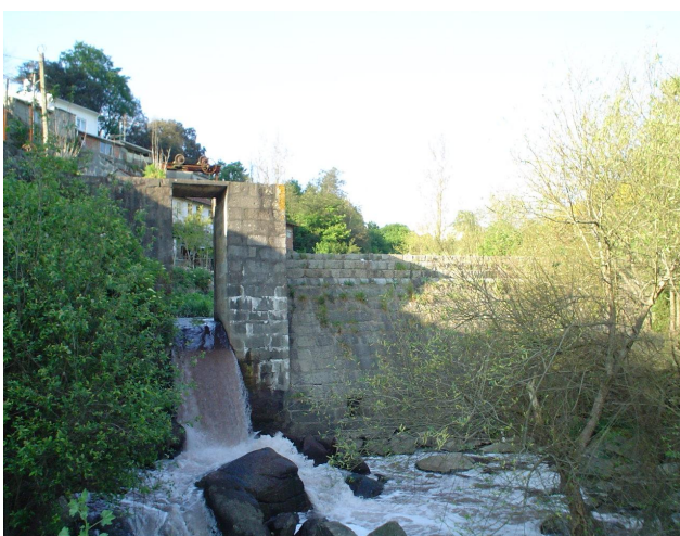
Foto 2 – Dique que alimentava a central hidroeléctrica da Empresa Industrial de Pevidém.
